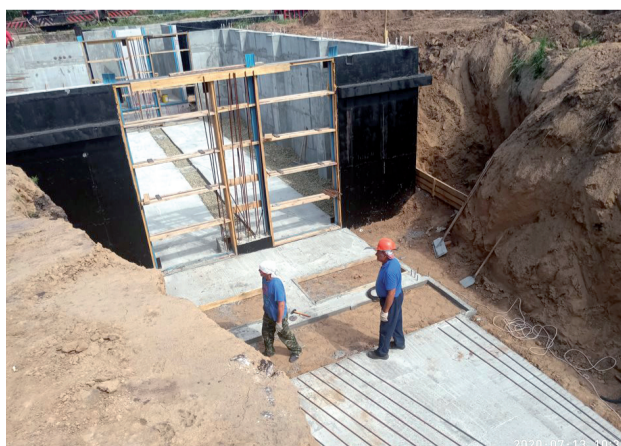
■ За год на станции будет проходить обработку порядка 36,5 млн кубометров сточных вод.
